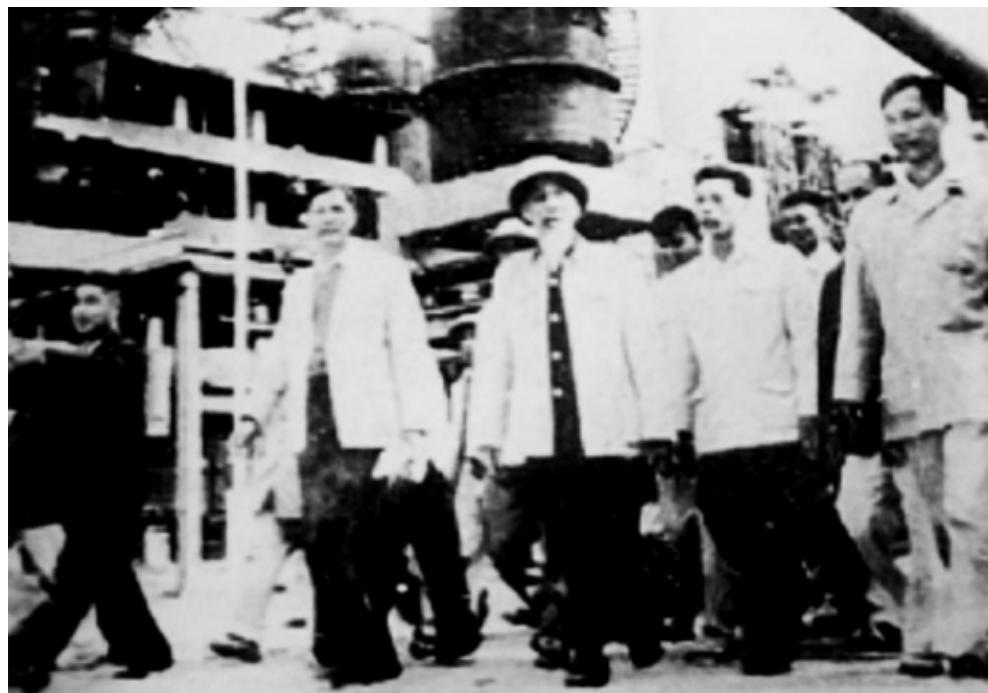
Chủ tịch Hồ Chí Minh về thăm Khu gang thép Thái Nguyên 1964 - công trình trọng điểm NH Kiến thiết cấp phát vốn
